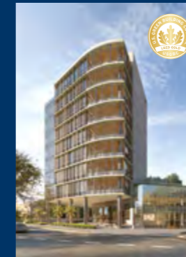
PVN – LEED Ouro
