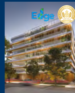
Corporate Garden LEED Ouro e Edge
